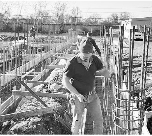
Идет сооружение фундамента
